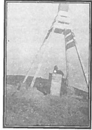
“Balıkesir yöresine işaret vermeye hazırlanmış birinci derece nirengi pilyesi ve piramit (1933).”
