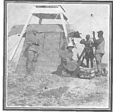
“Balıkesir yöresinde baraka içinde gözlemleri yapılan birinci derece nirengi noktası (1933).”
