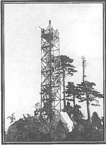
“Edremit bölgesinde Büyük Kataran Dağı’nda, Yzb.Münir Bey ve yardımcıları tarafından yapılan 18 metre yüksekliğindeki ağaç gözlem kulesi.”
