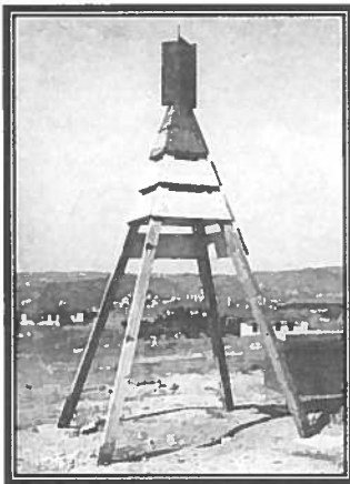
“Ağaçtan yapılmış ikinci derece nirengi noktaları için pilyesiz bir pramit.”
