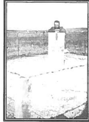
“Trakya’da yapımı biten birinci derece pilyesi (1934).”
