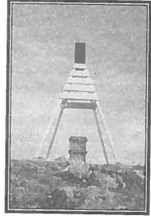
“Balıkesir yöresinde birinci derece pilyesi ve üzerinde piramit.” (1933)
