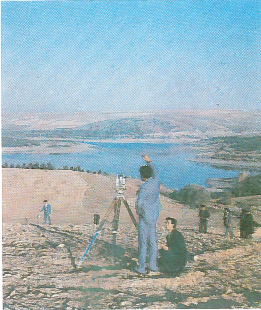
Elektronik Takeometre ile Arazi Üzerinde Araştırma Çalışması Survey Work on Field with an Electronic Tachymeter
