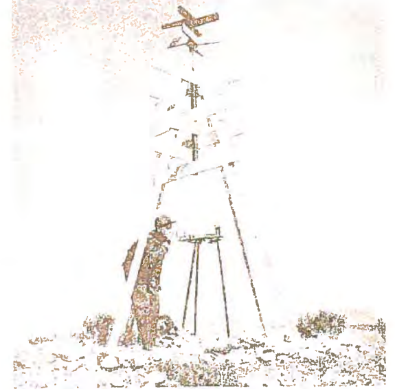
Gündüz Rasadı İçin Helyotropla Işık Tevhidi Reflecting Light with Heliotrope for Daytime Observation
