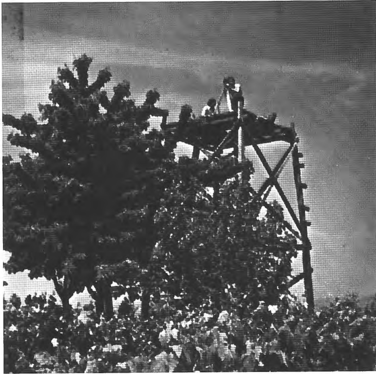
Görüşe Kapalı Alanlarda Kule Kurularak Yapılan Nirengi Açı Ölçüm İşleri The Triangulation Angle Measurement Processes Made by Building Tower at Invisible Places
