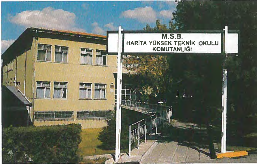
Harita Yüksek Teknik Okulu (1998) HARİTA GENEL KOMUTANLIĞI-2014 Survey Engineering School (1998)
