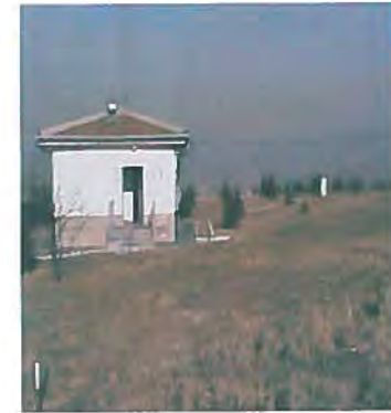
Sabit GPS İstasyonu, Ankara Permanent GPS Station, Ankara
