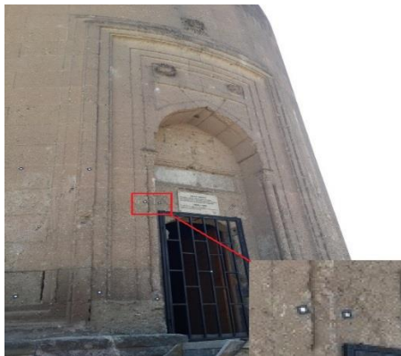
Şekil 4. Yapı Üzerindeki Hedef İşaretleri.
