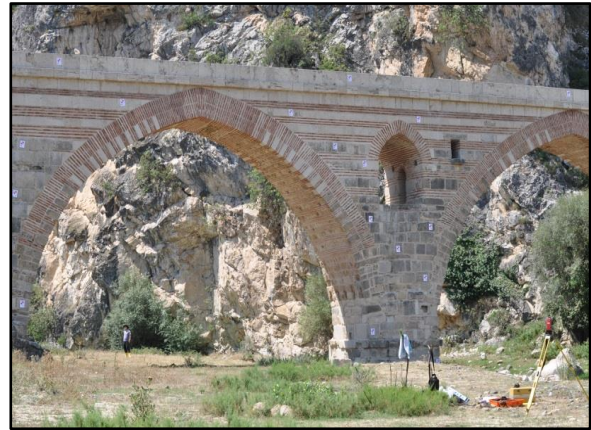
Şekil.3 Kontrol noktalarının tesisi ve ölçümü
