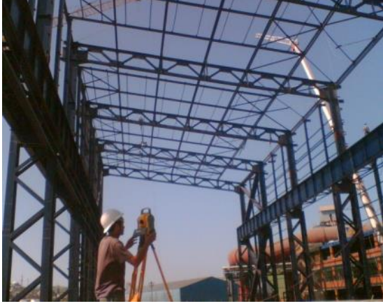
Şekil 7. Vinç raylarının ölçülmesi ve montajı
