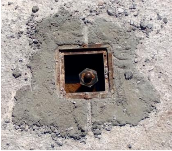
Şekil 4. Nivelman nokta tesisi
