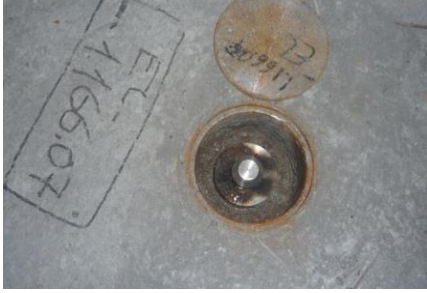
Şekil 3. Poligon zemin tesisi
