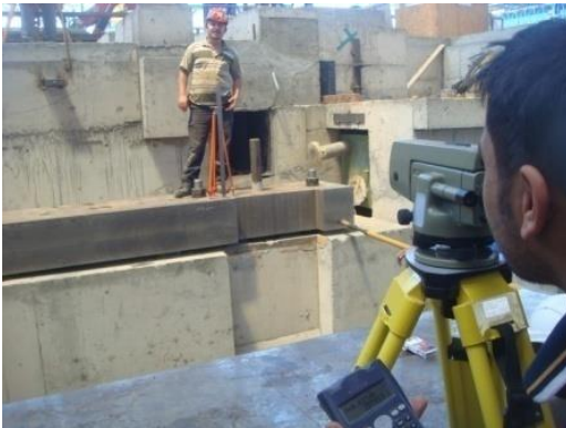
Şekil 11. Bedplate kotunun ayarlanması
