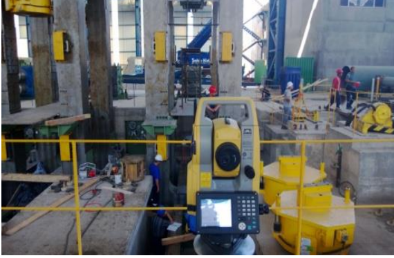
Şekil 13. Makine kurulumu için optik hizalama çalışmaları
