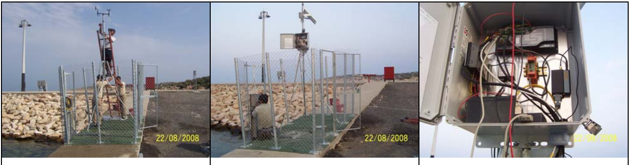
Şekil 2-13 : Üçayaklı direk üzerine güneş paneli ile meteorolojik sensörlerin montajı.
