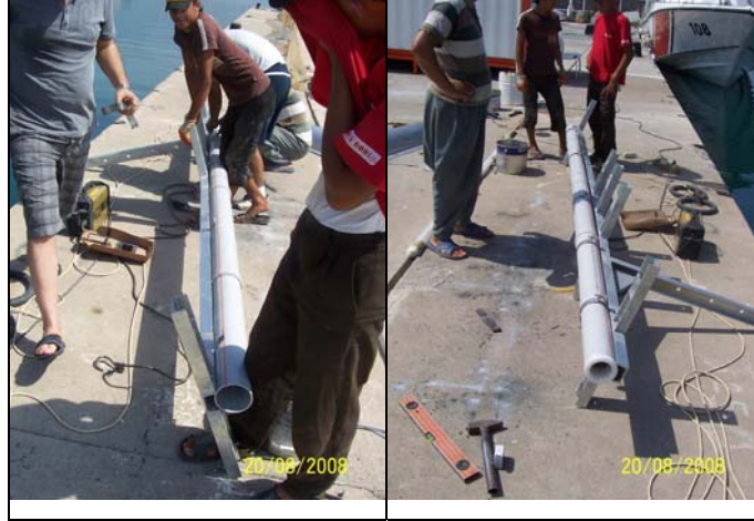
Şekil 2-8 : PVC borunun yerleştirilerek kelepçeler ile sabitlenmesi.
