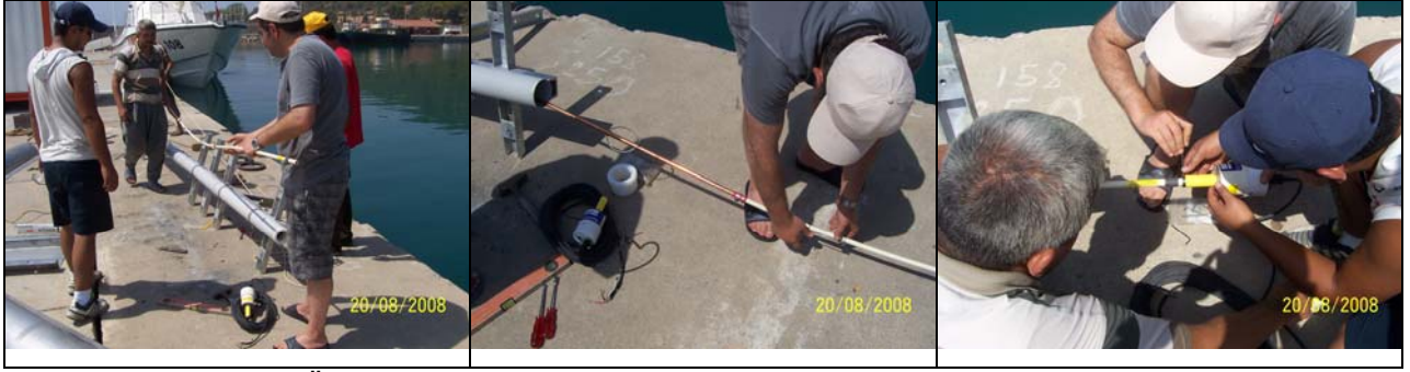
Şekil 2-9 : Ölçme sisteminin monte edilerek PVC boru içerisine yerleştirilmesi.
