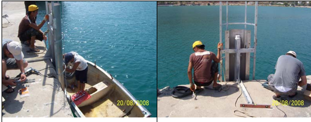
Şekil 2-11 : İskeletin platforma montajı.
