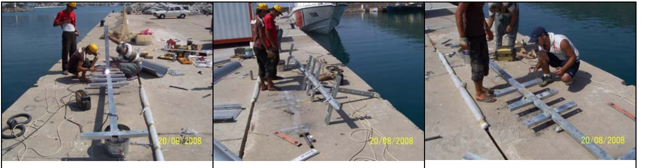
Şekil 2-7 : Seviye sensörünün yerleştirileceği iskeletin tesisi.
