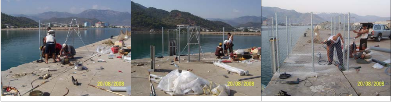
Şekil 2-12 : Üçayaklı direk ve tel örgünün tesisi, izolasyon malzemesinin serilmesi.
