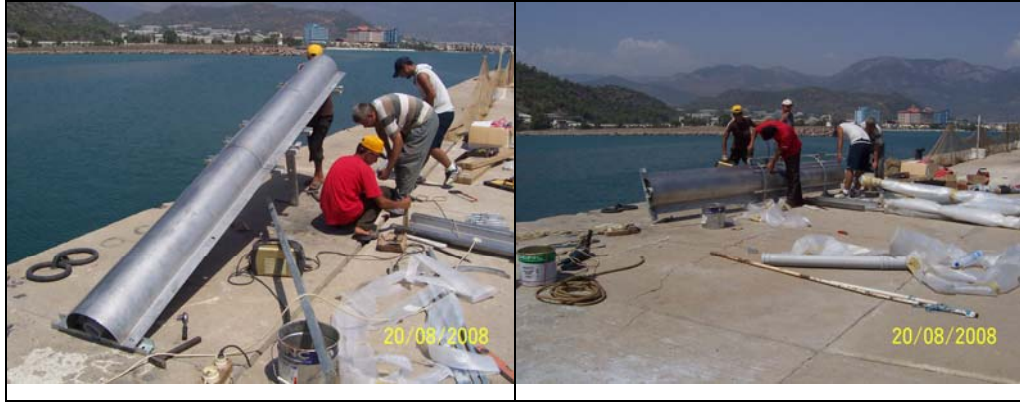
Şekil 2-10 : İskeletin krom sac ile kaplanması ve kuşaklanması.
