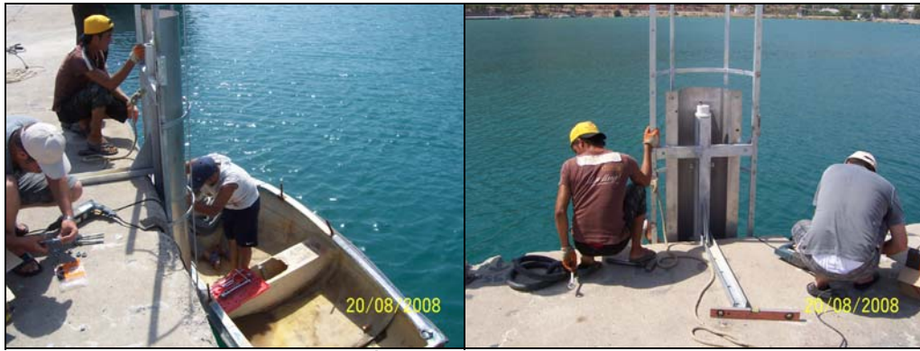
Şekil 2-13: İskeletin platforma montajı.
