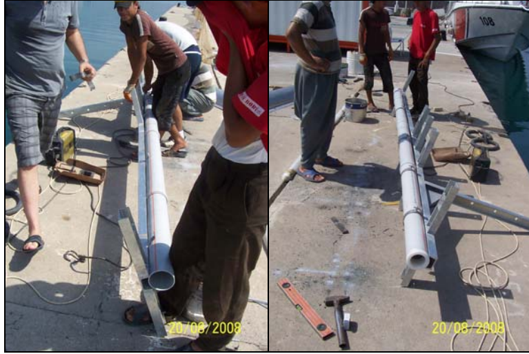
Şekil 2-10: PVC borunun yerleştirilerek kelepçeler ile sabitlenmesi.
