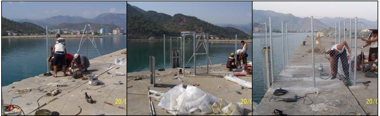
Şekil 2-14: Üçayaklı direk ve tel örgünün tesisi, izolasyon malzemesinin serilmesi.
