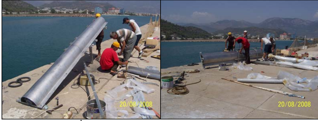
Şekil 2-12: İskeletin krom sac ile kaplanması ve kuşaklanması.
