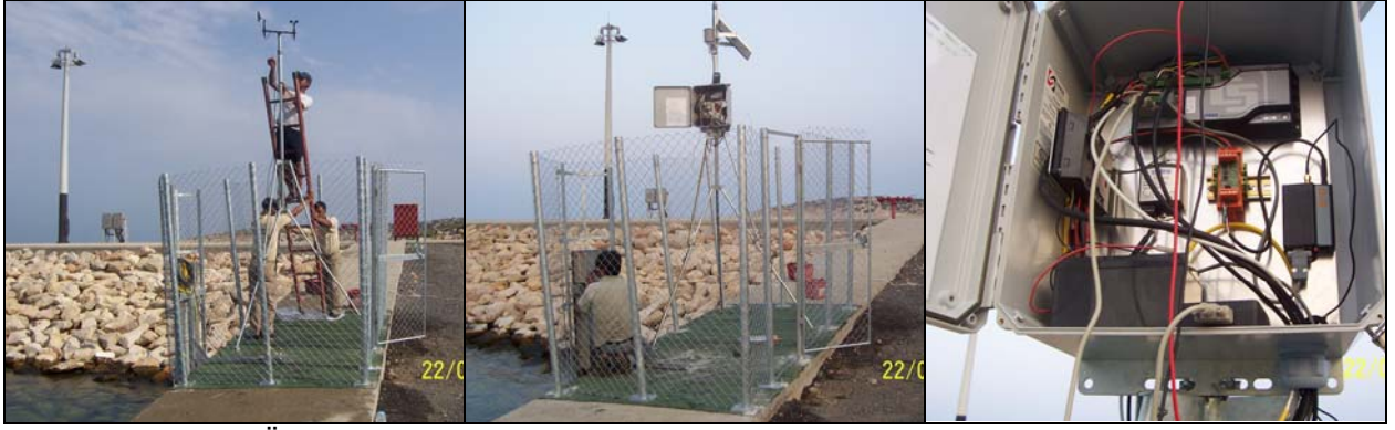
Şekil 2-15: Üç ayaklı direk üzerine güneş paneli ile meteorolojik sensörlerin montajı.
