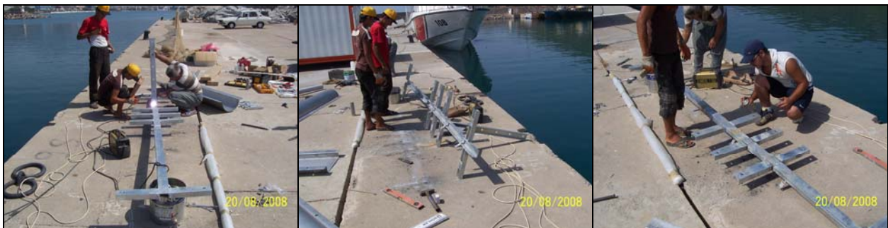
Şekil 2-9: Ölçme sensörünün yerleştirileceği iskeletin tesisi.
